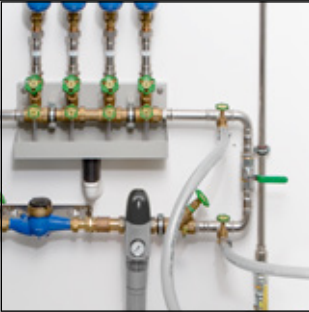
Spülen von Trinkwasserinstallationen mit Wasser oder Wasser/Luft-Gemisch 1)3)4)
